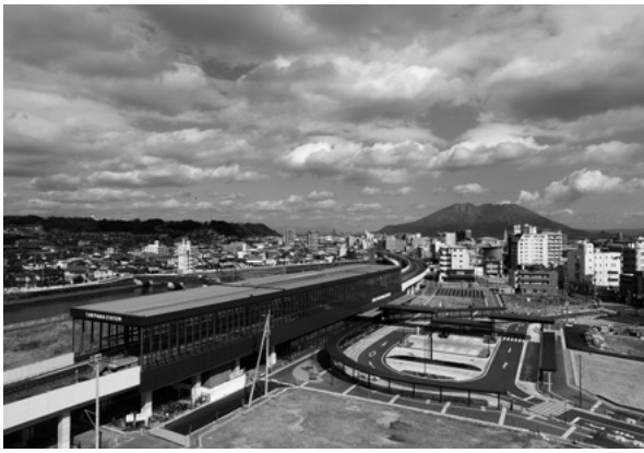
高架化されたJR指宿枕崎線の谷山駅周辺
