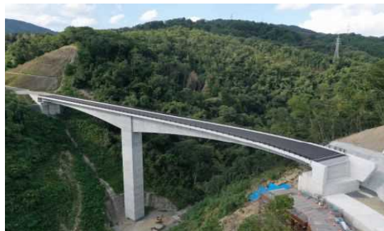
安威川ダム7号橋
