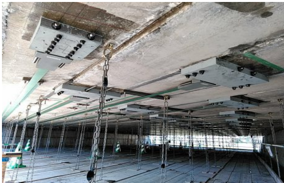
上部工の補修工事
