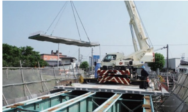
床版の補修工事
